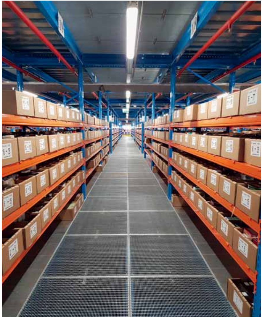
Полы мезонина представляют собой прессованный решетчатый настил Источник: FM Logistic
